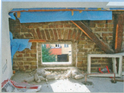
Die vorhandenen Fensteröffnungen wollte man weiterhin nutzen und hat deshalb nur die alten, maroden Holzfenster ausgebaut.
