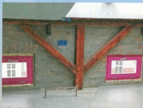
Die neuen Fenster nehmen das frische Magenta wieder auf, die Backsteinwand wurde gereinigt und neu verputzt, das Holzgebälk saniert und geölt.
