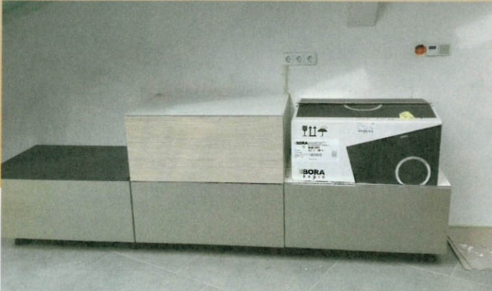
Die Kochzeile steht auf einem vertieften Sockel und wirkt dadurch schwebend und leicht. Die formale Anpassung an die Dachschräge, unter der sie ja steht, erfolgt alleine durch die Abstufung bzw. den Versatz der Korpusse (vgl. S. 41).
