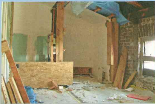
Kaum vorstellbar, dass hier ein ambientereiches Refugium entstehen wird. Aber unser Bauherr wusste, was er tat: Entkernung bzw. Öffnung war Schritt Nummer 1.
