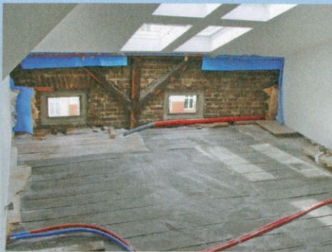
... aufgebaut, zumal auch für die neuen Rohre und Leitungen Platz geschaffen werden musste. Hier der bestehende Blindboden aus Rauspunddielen.
