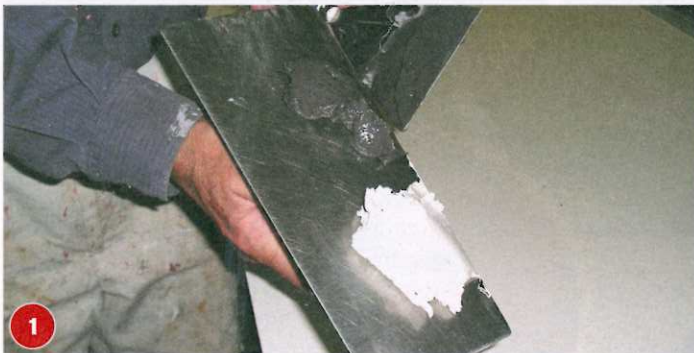
1 Den Kalkspachtel abtönen und in 1 mm Stärke auftragen. Nach dem Trocknen die Spachtelmasse in zwei Stärken herstellen: erst Weiß, dann Anthrazit. Je einen Klecks auf die Kelle geben.
