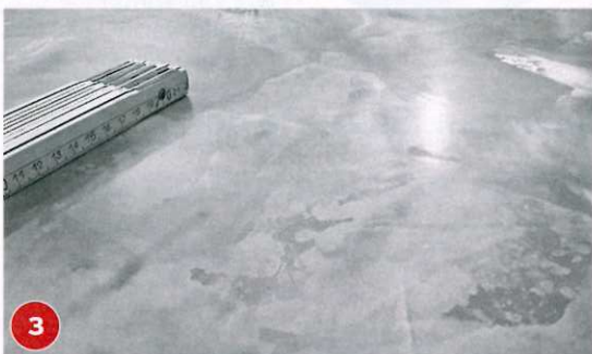
3 Kurz antrocknen lassen, mit der Venezianerkelle verdichten und mit dem Auro-Wandlasurwachs farblos wachen und polieren.
