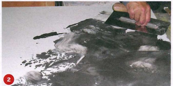
2 Die Spachtelmassen kreuz und quer auftragen, sodass sich beide Farbtöne unterschiedlich stark miteinander vermischen. Behutsam vorgehen, damit die Textur kontrastreich bleibt.
