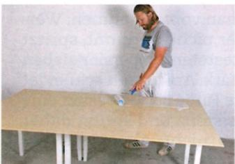
Der Kleister für die Tapeten wird flächig und satt aufgerollt
