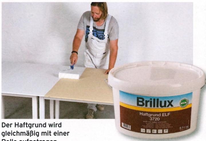
Der Haftgrund wird gleichmäßig mit einer Rolle aufgetragen
