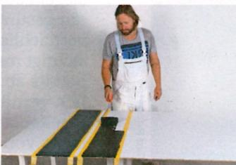
Anschließend wird der abgeteilte Bereich zweifarbig gestrichen
