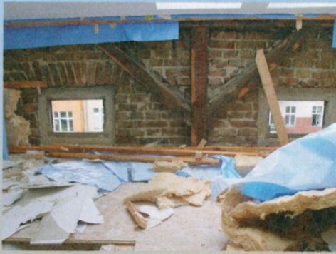
Freilegen und öffnen: Bei diesem Dachausbau war beides vonnöten, um später die besonderen Effekte zu bekommen. Auch der Fußboden wurde neu ...
