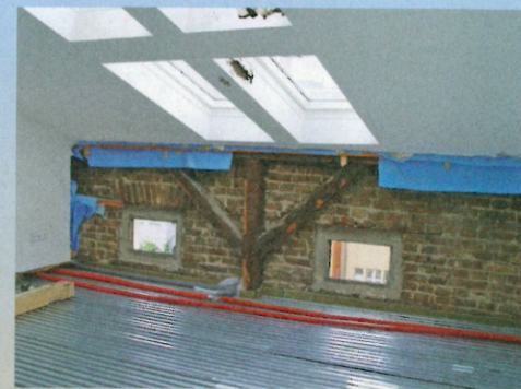
Während oben die Dachschrägen schon fertiggestellt waren, verlegte man am Boden spezielle Bleche für die neue Estrichauflage.
