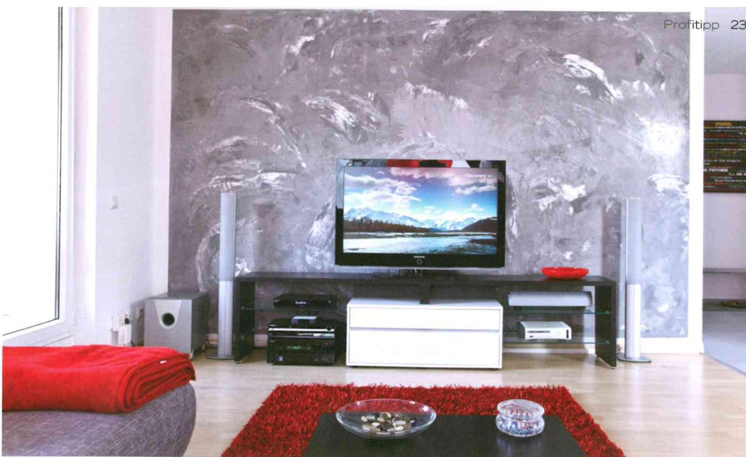
gutes Resultat schön in schwunghaften Zügen arbeiten, bis der erwünschte Seidenglanz entsteht. Am besten ist eine Schichtdicke von maximal einem Millimeter. Ist die Fläche fertig gespachtelt, sollte die Wand zwölf Stunden trocknen. Wer noch mehr Glanz und Schutz haben möchte, kann zusätzlich jetzt farbloses Wandlasur-Wachs mit einem Baumwolltuch auf die Fläche polieren. So entsteht nach kurzer Zeit eine seidenglatte, glänzende Oberfläche.
