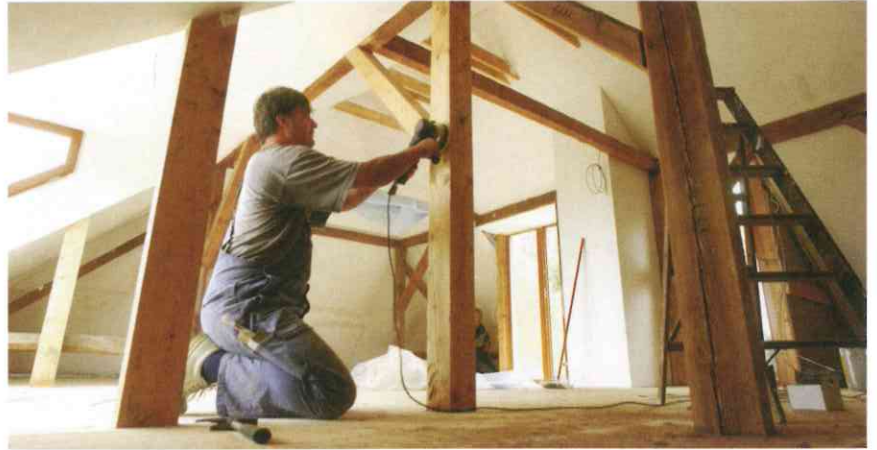
Vor dem Dachausbau sollte man eine Fachkraft vor allem den Dachstuhl auf Belastung mit PCP- und Lindan-haltigen Holzschutzmitteln hin untersuchen lassen. BSB
