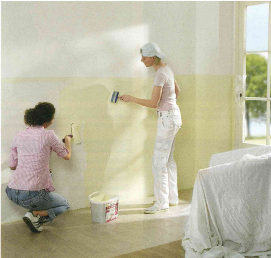
Der „1-2-3-Rollputz“ von Ceresit kann nach individuellem Geschmack eingefärbt werden. Aufgetragen wird er ganz einfach mit der Rolle. Danach lässt er sich entweder mit der Strukturrolle, der Walze oder mit dem Pinsel strukturieren.
