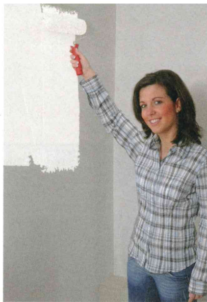
Am einfachsten lässt sich gebrauchsfertiger Rollputz, beispielsweise von Fermacell, an die Wand bringen. Foto: Fermacell
